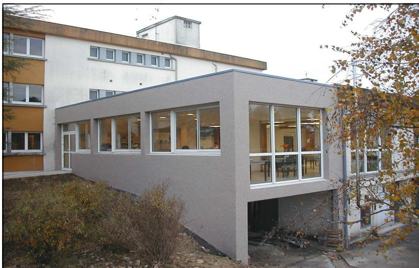
Extension de la salle à manger
