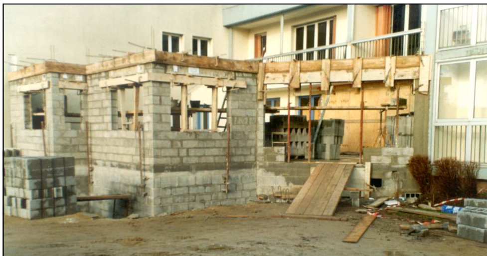
Travaux d'extension pour les bureaux
